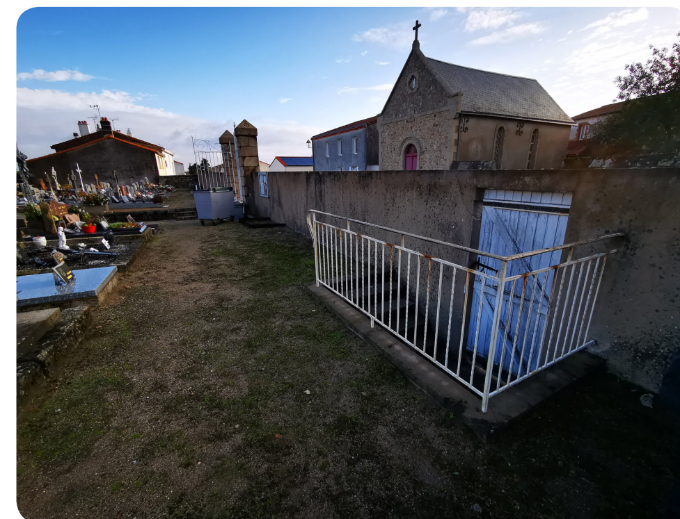
Un accès annexe à l'angle Sud du C1.
