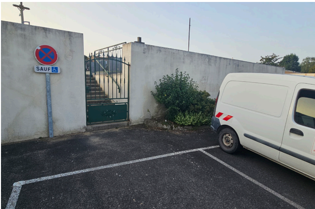
Accès C1 depuis le parking du cimetière
